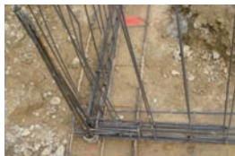
Nœud de chaînage - Continuité mécanique
