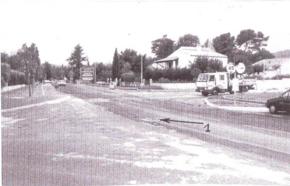
GRABELS - R.D. 127 face à l'entrée du lotissement "Les Cigales" : en 1976, il y avait 0,45 m d'eau sur la chaussée.
