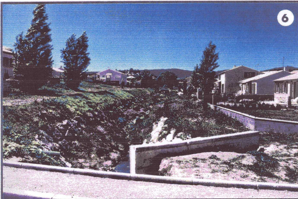
Ouvrage à l'aval du lotissement le Champ Vert
