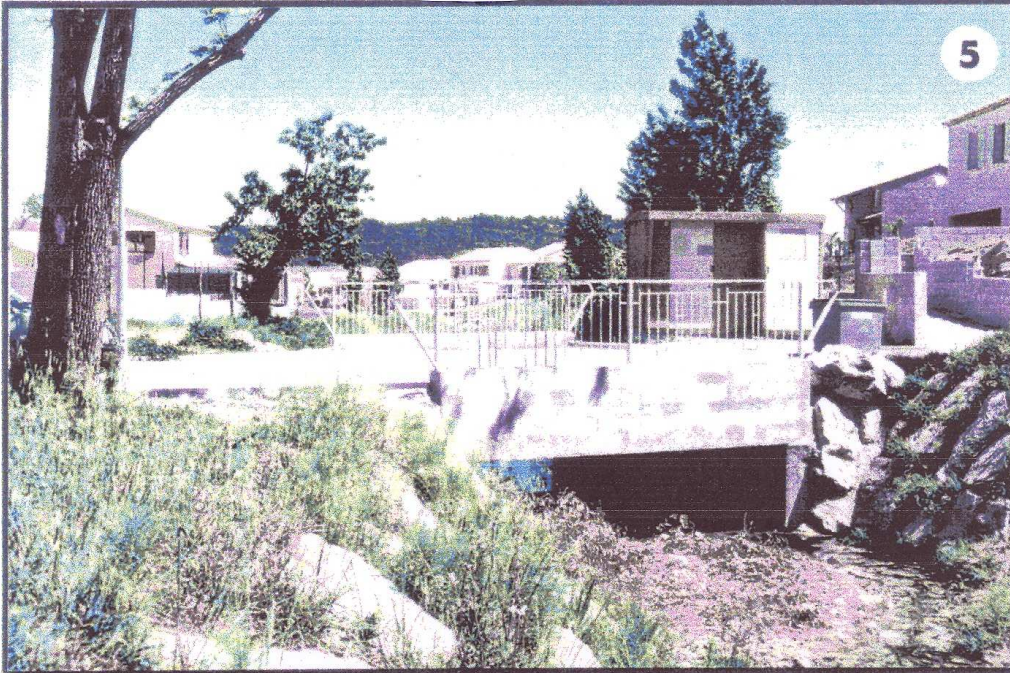
Ouvrage limitant dans le lotissement - Transformateur vulnérable
